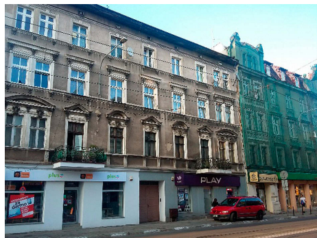
Zły stan techniczny
