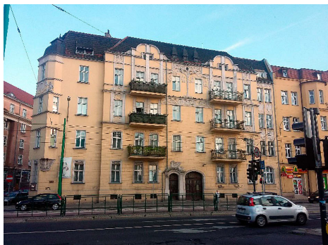
Dobry/zadowalający stan techniczny
