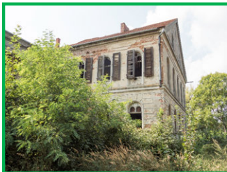
KR_2.3a Pałac w poł XIX wieku. Choć obecnie w bardzo złym stanie technicznym to jednak jest on elementem charakterystycznym wsi, identyfikowalnym i wzbudzający ciekawość osób przyjezdnych.
