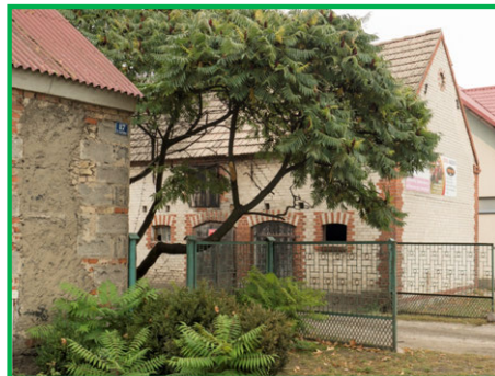
GB_2.4c Budynek gospodarczy z cegły wapienno-piaskowej z detalem klinkierowym, jednokondygnacyjny plus poddasze, drzwi i okna posiadają opaskę, w górnej części budynku zakotwienia (ankry), dach dwuspadowy, stromy
