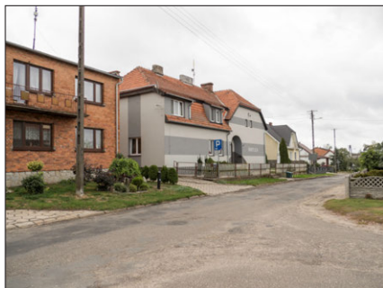
ST_D1 Rząd budynków o bardzo dużej kubaturze, kolorystyka niespójna. Sala wiejska pomalowana w pionowe i poziome pasy.
