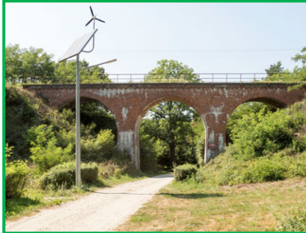
NO_2.2b Wiadukt z 1908 roku. Linia kolejowa obecnie nieczynna, tory użytkowane pod drewno.
