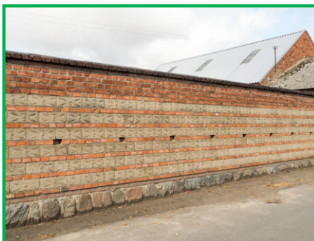
SK_3.3b Mur kładziony naprzemiennie z cegły palonej i bloczków betonowych na podmurówce kamiennej.
