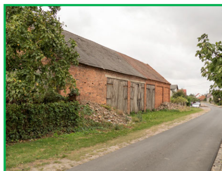
SK_2.3b Stodoła z dużymi otworami drzwiowymi. Budynek gospodarczy z cegły palonej, zakotwienia belek konstrukcyjnych są ozdobne, dach dwuspadowy o koncie nachylenia 25-30°, widoczne miejsca wentylacyjne. Budynek użytkowany.
