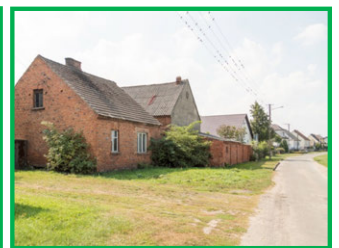
KR_2.3d Ciąg budynków w układzie historycznym, dobrze zachowane, pokazujące ówczesną specyfikę budowy (proporcje części mieszkalnej i poddasza, układ i wielkość otworów okiennych, detal konstrukcyjny).
