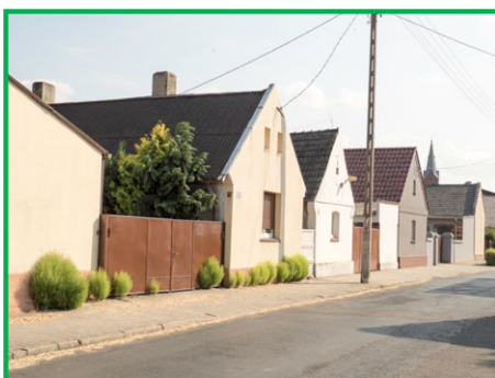
KO_2.3a Ciąg zabudowań. Zachowana linia domów, brak przekształceń, równa linia dachów i okien, spójna kolorystyka.
