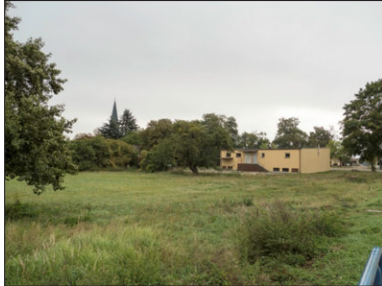
GB_D1 Budynek na wjeździe do wsi od strony zachodniej. Wymaga działań remontowo-adaptacyjnych i zmieniających wizerunek.
