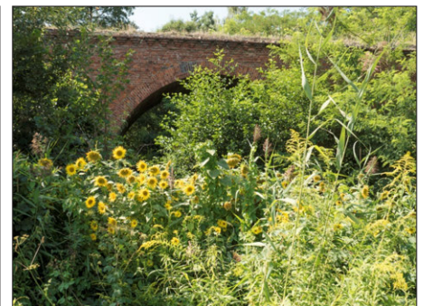
NO_6.2c Wiadukt kolejowy (nieczynny) jako potencjalne miejsce na punkt widokowy.
