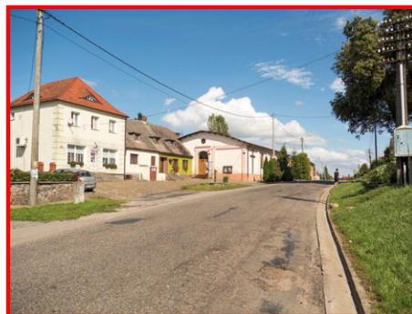
ŁK_1.3b Plac przy kościele wraz z przyległymi zabudowaniami.
