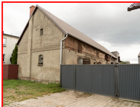
SW_2.4b Budynek gospodarczy, aktywnie wykorzystywany, z wyremontowanym dachem, którego forma jest zgodna z dotychczasowym, lokalnym sposobem budowy. Widać dwudzielność kondygnacji, zachowanie oryginalnych otworów okiennych i drzwiowych, budynek wtórnie otynkowany.
