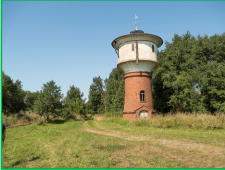
NO_2.2a Wieża ciśnień z 1907 roku.
