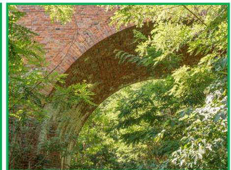
NO_2.3c Wiadukt ceglany z pocz. XX wieku, dobrze zachowany.
