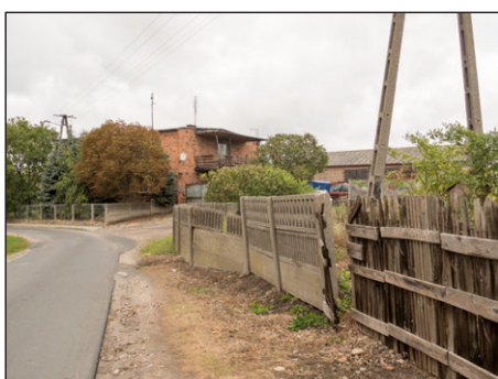
SK_D4 Zły stan techniczny ogrodzeń
