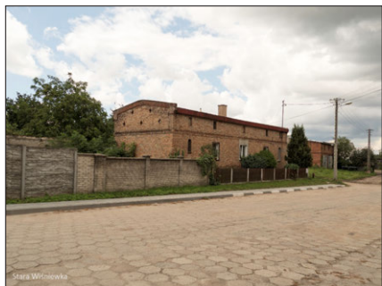
SW_D1 Duże połączenia wybetonowanych ciągów komunikacyjnych z betonowymi prefabrykowanymi ogrodzeniami kontrastują z historyczną zabudową.
