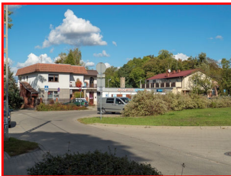
OW_3.1b Budynki mieszkalne z usługami w parterze w centrum wsi. Obiekty o miejskim wyglądzie sąsiadują z Doliną Warty oraz zespołem poklasztornym.
