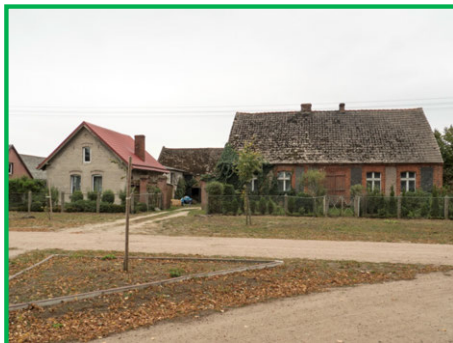
GB_2.4b Budynki mieszkalne ukazujące historyczne przemiany w sposobie zabudowy. Jeden zbudowany z cegły wapiennej (silikatu), okna wtórnie osadzone z zachowaniem dawnego podziału, dach wymieniony z zachowanym spadkiem. Bardzo dobry przykład poprawnych przemian.
