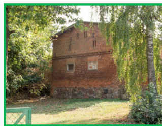
KR_2.3c Budynek gospodarczy przy głównej ulicy, widoczne charakterystyczne dla tego typu zabudowy otwory wentylacyjne i ozdobne gzymsy. Widoczne zmiany w kształcie otworów okiennych.
