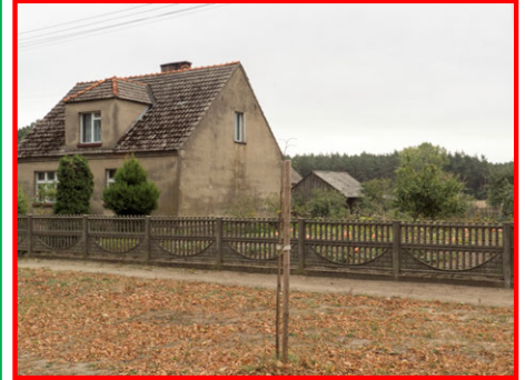
GB_3.2c Betonowe ogrodzenie kontrastuje z historyczną zabudową zagrodową i malowniczym dyniowym ogrodem.
