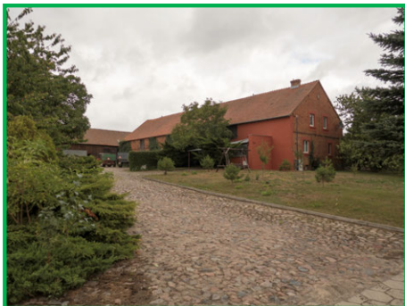
SK_3.1a Zabudowania mieszkalne i gospodarcze wewnątrz posesji – przykład przekształceń pozytywnych (zachowana kubatura, kolorystyka zbliżona do ceglanej, zachowane oryginalne otwory okienne).
