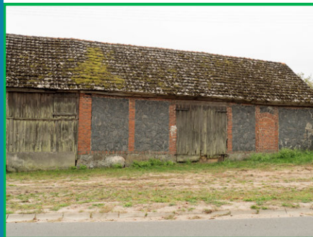
GB_2.4a Budynek gospodarczy murowany. Materiałami budowlanymi była cegła i kamień. Stodoła dwudzielna (część przeznaczona na produkty rolne, część na sprzęt rolniczy).
