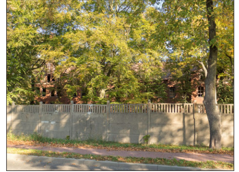
OW_D3 betonowe ogrodzenie kontrastujące z ceglana zabudową i parkiem nieużytkowanego zakładu dla psychicznie chorych z k.XIXw.
