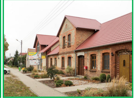
GB_2.2c Dom murowany tynkowany z detalem z cegły licowej; widoczne opaski okienne, licowane i główkowe ornamenty z cegły, dach 45° pokryty blachodachówką. Budynek jest odremontowany, właściciel zachował ważne i wartościowe kulturowo detale architektoniczno-budowlane.
