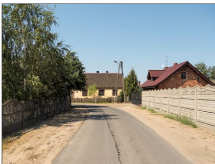
ZB_D1 Płoty betonowe po obu stronach drogi, brak chodników.
