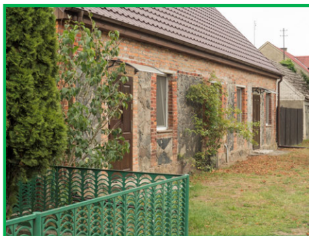
GB_2.3a Budynek mieszkalny murowany, licowany cegłą i kamieniem. Okna i drzwi wymienione aczkolwiek ujęte w historyczne otwory okienne.
