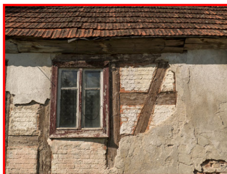
ŁK_2.21b Fragment budynku ukazujący szachulcowy sposób budowy. Obecnie budynek opuszczony, w bardzo złym stanie technicznym, nadający się do gruntownego remontu lub rozbiórki.
