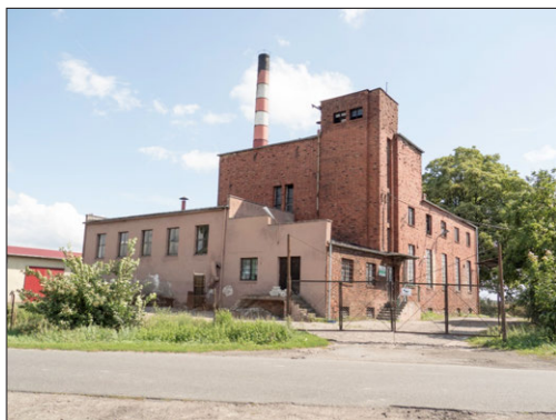
ŁK_D1 Opuszczony budynek przemysłowy. Kolorystycznie dopasowany do istniejących w sąsiedztwie zabudowy. Niszczące.
