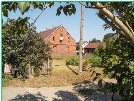
NO_2.4a Budynek mieszkalny, obok w tle gospodarczy. Oba wzniesione z cegły palonej, murowane, dachy dwuspadowe pokryte blachodachówką w kolorze odpowiadającym, okna zmienione.
