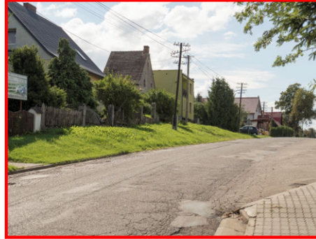
ŁK_1.2b Ulica w centrum wsi, widok w kierunku zachodnim.
